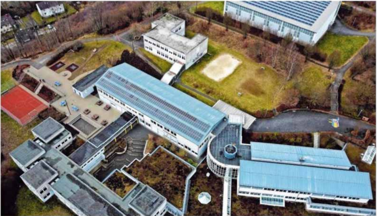
Hier sollen bald die Bagger anrollen: Das Gymnasium Netphen benötigt einen Erweiterungsbau, um den steigenden Schülerzahlen gewachsen zu sein. Foto: Björn Hadem
